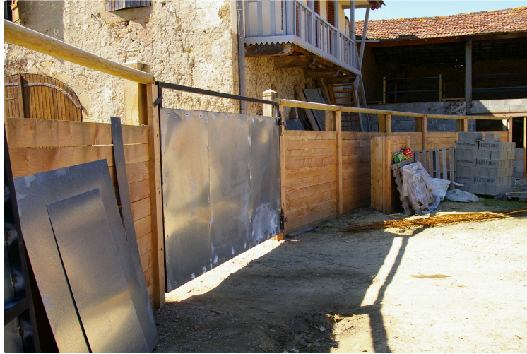
Les travaux avancement au "Corral" du Lartet
