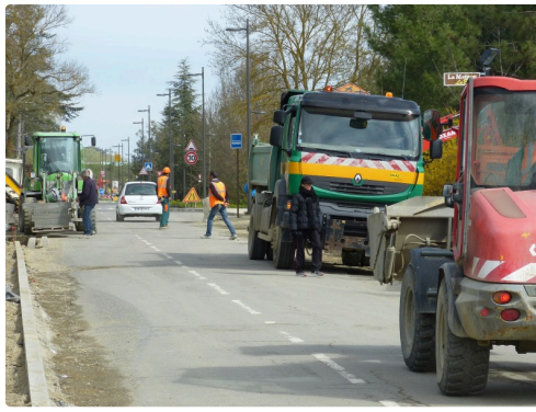
rue du 8 mai, quel chantier !
