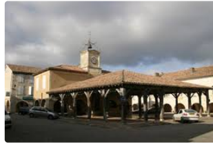
SAINT CLAR - Travaux sur le réseau d'adduction d'eau potable
