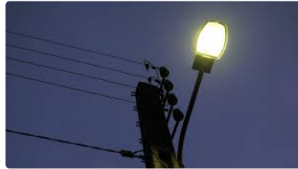
L'Isle Jourdain : extinction des feux
