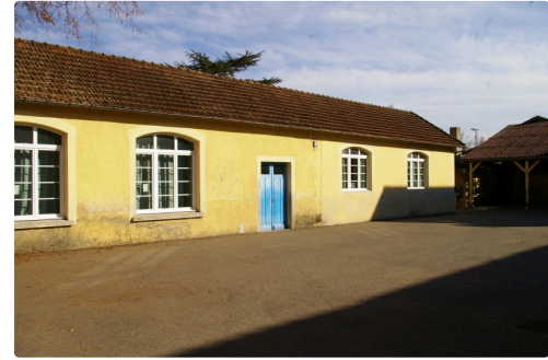
Le bâtiment actuel répertorié N° 2 situé coté rue Basse
