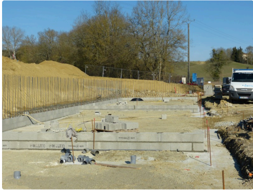
.Première dalle du bâtiment qui pourra accueillir 140 box
