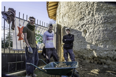
On décape aussi à l'autre bout du bâtiment
