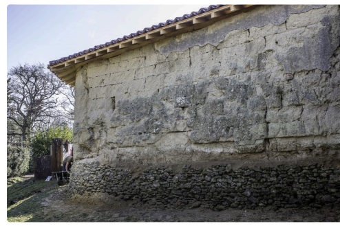
Ce mur n'étant plus abrité par un toit très débordant, un renfort de pierres ultérieures protège de la pluie le bas du mur
