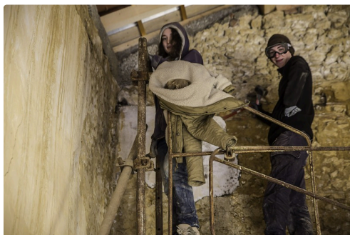
Les murs intérieurs aussi sont décapés
