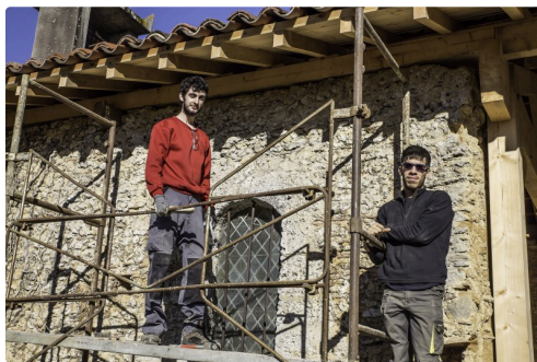
Décapage du mur extérieur
