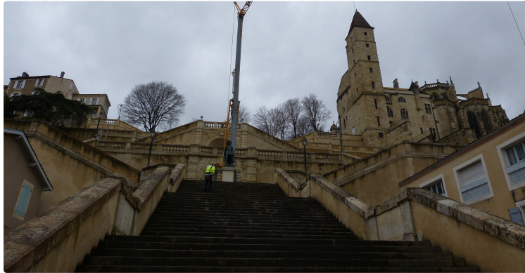
AUCH : ESCALIER MONUMENTAL
