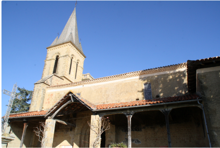
Sainte Dode : Rénovation de l'église
