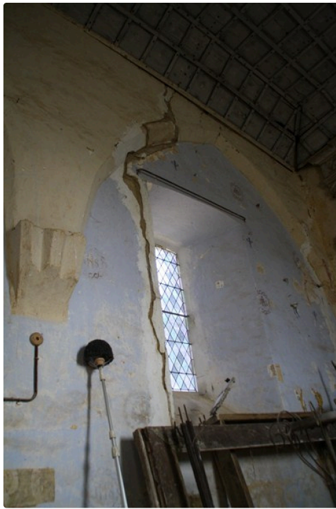
Le sanctuaire à rénover
