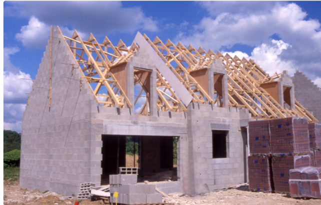
Constructions : passage par la case architecte dès 150m 2
