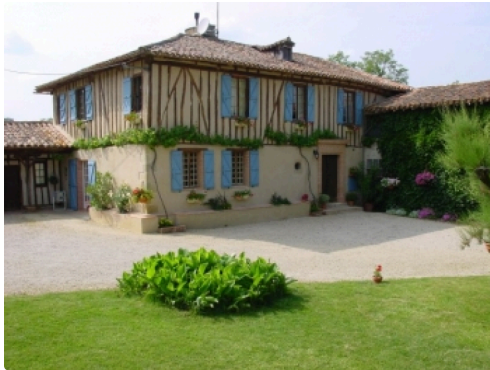
Maison de caractère à Montamat
