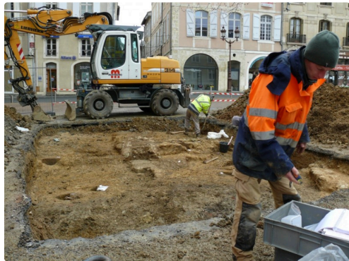
Vue globale du chantier.
