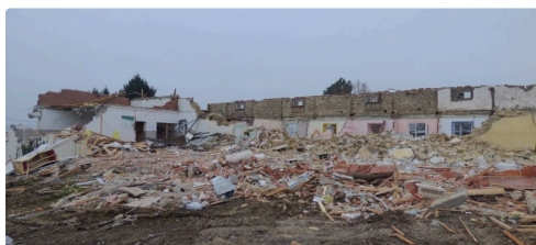
une vue d'ensemble du chantier de démolition
