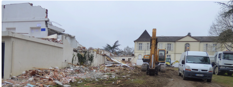
La rénovation du chateau d'Espagnet
