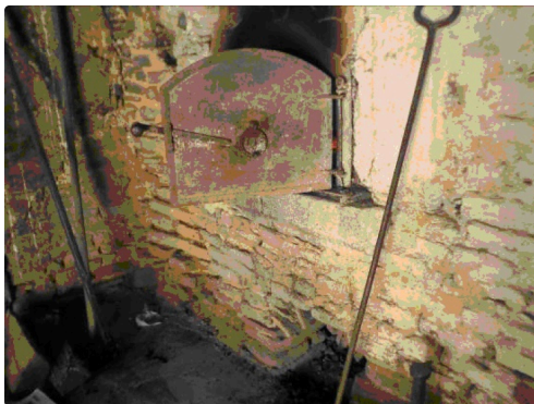
Détail de la porte du four
