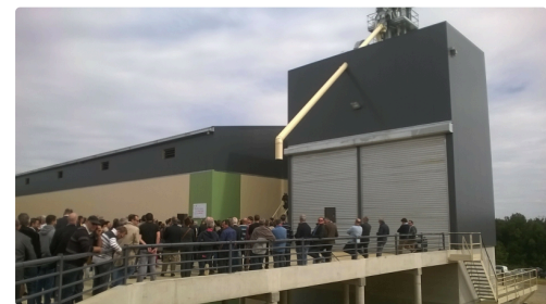
Les nouveaux silos Crédit Photo RMP
