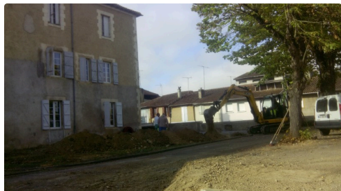
maison de santé travaux 2.jpg
