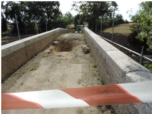
Des travaux nécessaires
