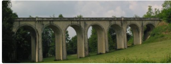
Castin : Le viaduc et le tunnel sont interdits de toute circulation motorisée
