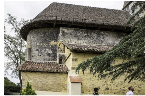
L'arrière de l'église inscrite aux Monuments historiques à cause de son mur en terre
