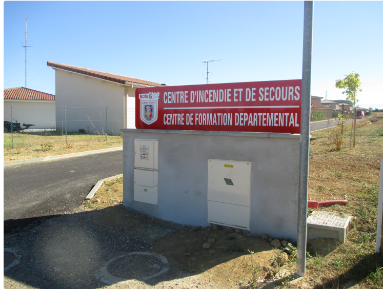
Le nouveau centre de secours
