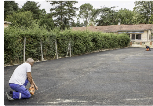
Pose des limites sur le parking de l'autre côté de l'avenue des Pyrénées par rapport à la cité scolaire
