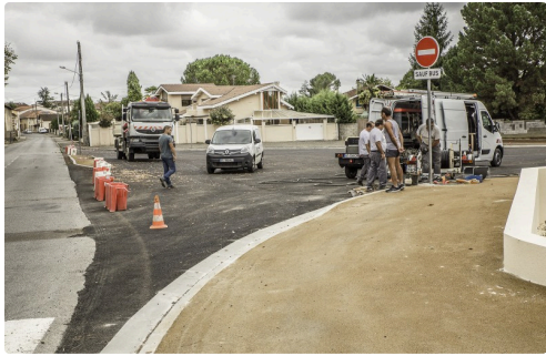
Arrivée à Nogaro depuis Riscle ; des travaux d'éclairage public sont en cours
