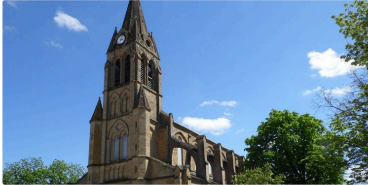
Travaux de réhabilitation de l' Eglise
