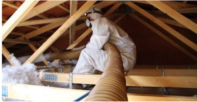
Travaux d'amélioration énergétique : soyez vigilant
