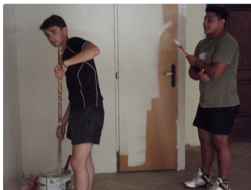
Travaux de peinture
