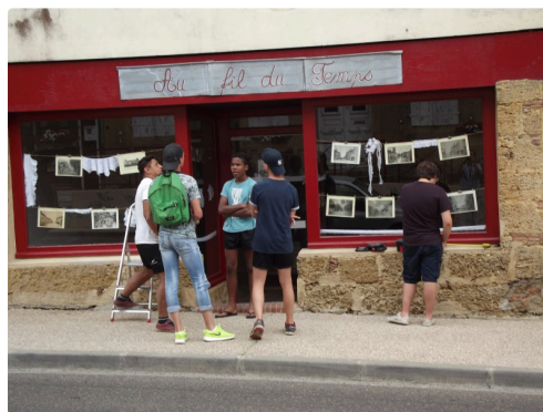
Rénovation d'une vitrine abandonnée
