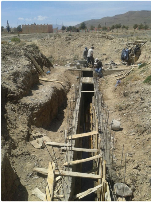
Travaux de restauration des canaux d'irrigation (Copier).jpg
