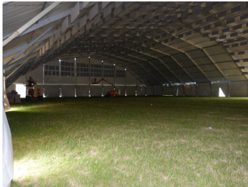
L'intérieur de l'immense chapiteau avant les aménagements intérieurs
