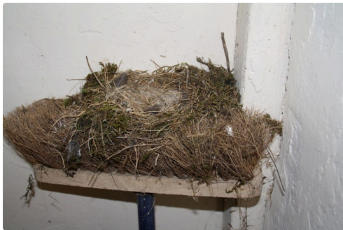
Chapelle de Goutz un logement abandonné
