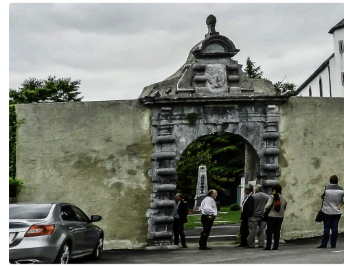
Portique du château d'Aramits
