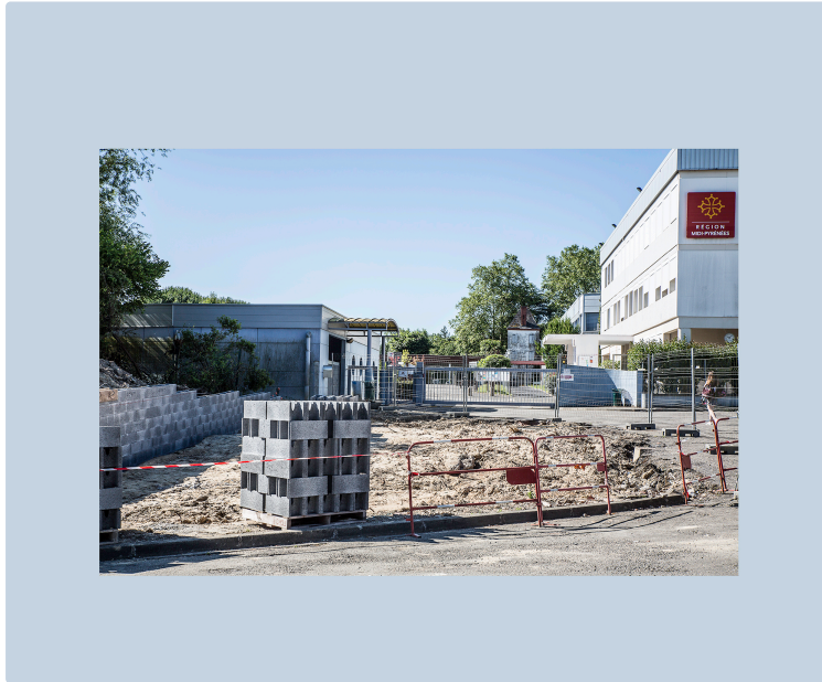
Nogaro : la place devant la cité scolaire est agrandie et rénovée
