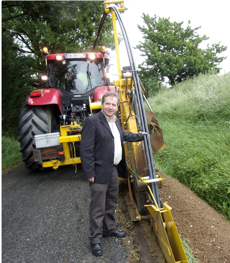
Noilhan : le passage du câble
