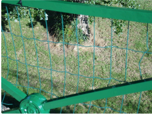
Ainsi sécurisé les enfants ne pourront pas passer a travers
