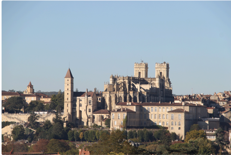
Restauration de la charpente et de la couverture du transept de la cathédrale d'Auch
