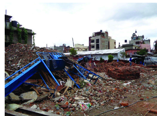
L'école Suryodaya après le séisme du 25 avril 2015.
