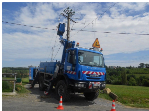
Gros engin à plate forme bien adapté et plus ....confortable
