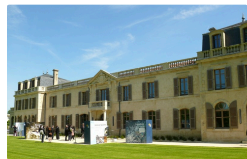
Façade sud de la cité de la transition énergétique.
