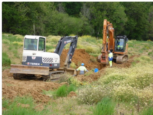
Une creuse la tranchée l'autre recouvre aussitôt
