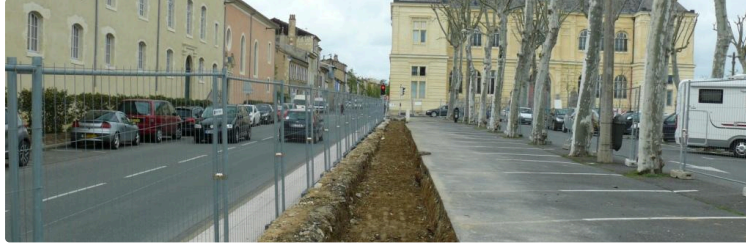
Balustrade des allées d'Etigny : la rénovation se poursuit
