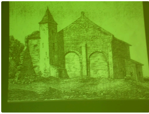
Une représentation de l'église en partie démolie
