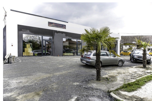
Façade du nouvel ensemble
