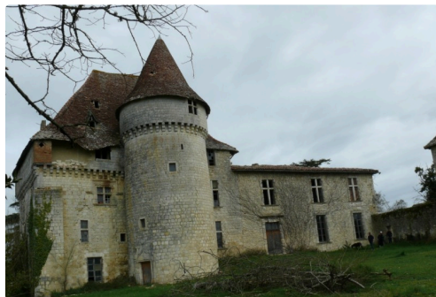
Face sud du château.
