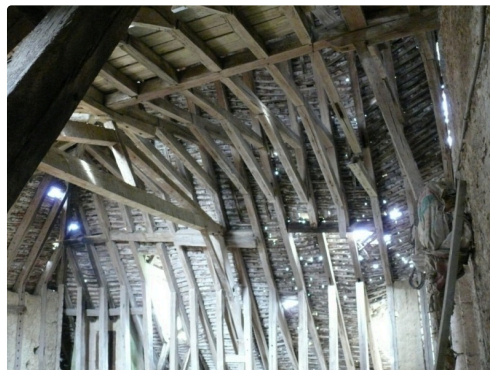
La charpente en forme de coque de bateau retourné.
