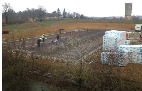
Vue des travaux.
