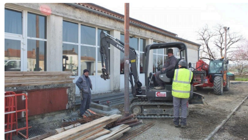
Les travaux de la salle des fêtes vont bon train.
