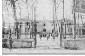
Les ultimes travaux au collège Pasteur
