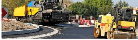
TRAVAUX SUR LA RN 124 DANS LA TRAVERSE DE VIC-FEZENSAC
