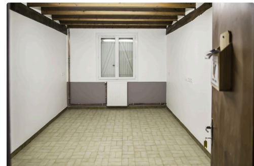
Une autre salle du rez-de-chaussée
