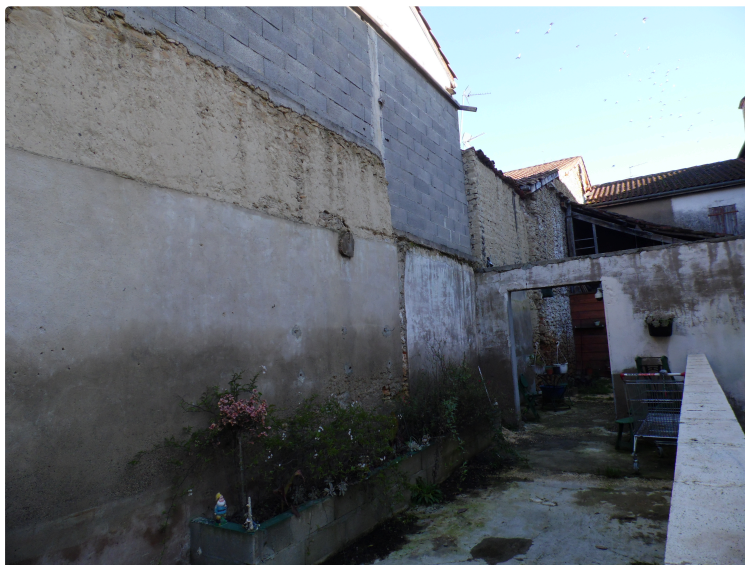
Les travaux de réhabilitation de l'Espace Jeunes ont débuté
