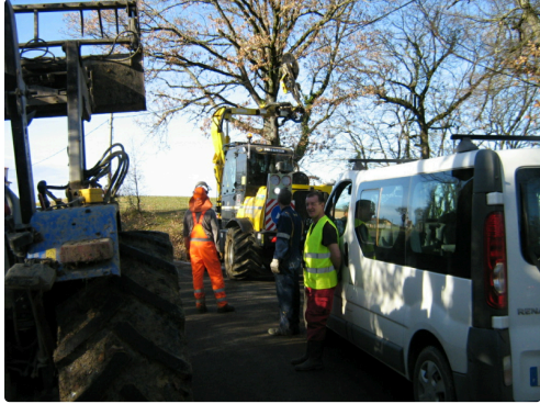
Les branches sont sciées à l'aplomb des chaussées
