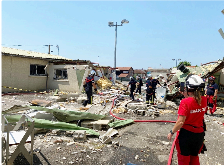
Enorme explosion dans un local de stockage associatif
