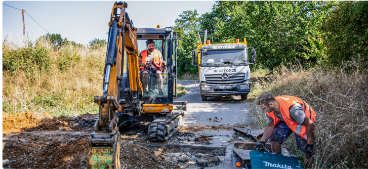
Waouh ! Le réseau Internet à Bouzon-Gellenave a été réparé !
