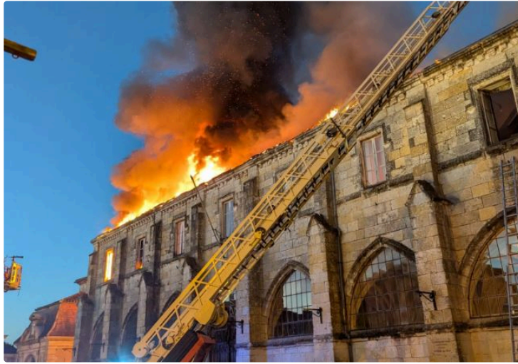
Le cloître de la cathédrale de Condom très endommagé par un incendie
